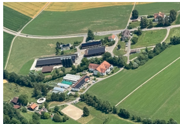
Blick auf den imposanten Götschihof: Sonnenenergie am Tag und Biogas in der Nacht für nachhaltige, unabhängige Energieversorgung.
