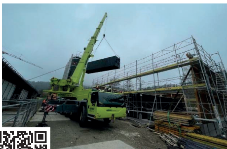
Oben: Grundsteinlegung Unten: Einbringung des Biogasfermenters
