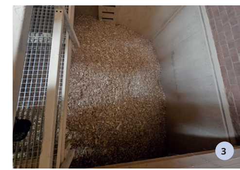
Bild 1, 2: Anlieferung und Installation des BHKW Bild 3: Die Hackschnitzel werden dem BHKW zugeführt Bild 4: Bei einem Betriebsrundgang erkunden interessierte Besucher den Energieturm. Bild 5: Die eindrucksvolle PV-Fassade des Energieturms auf dem Areal Lindauer
