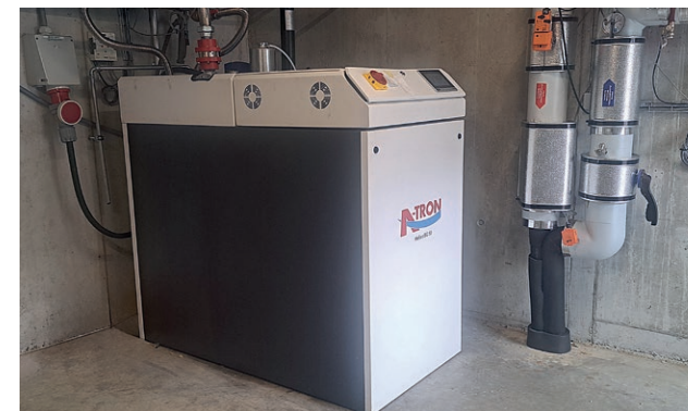
Links: Das Projekt «Leonardo» stösst in der Branche und in der Fachwelt auf grosse Resonanz: Dani Buchli vom Götschihof erklärt den Besuchern das Separationssubstrat. Rechts: Das Blockheizkraftwerk BHKW der Firma A-Tron kann 50 kW elektrisch erzeugen.
