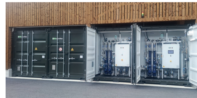
Gelungene Transformation vom traditionellen Grossviehmastbetrieb zu einem nachhaltigen Energiebauernhof. Von der Hofbiogasanlage als zentralem Element können täglich bis zu 15 Tonnen Rindergülle in Biomethan umgewandelt werden. Dieses wird in einem Blockheizkraftwerk zur Strom- und Wärmeerzeugung genutzt.
