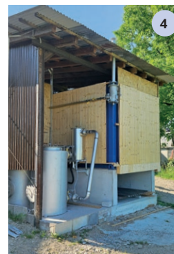
Bild 1: Der Hof Tschannen im schönen Thurgau Bild 2: Gasverdichter gut verpackt Bild 3: Grosser Gasspeicher im Container Bild 4: Fermenter und Gasreinigung unter einem Dach Bild 5: Blick in den Blockheizkraftwerkraum Bild 6: Der Maschinenraum des Festbettreaktors
